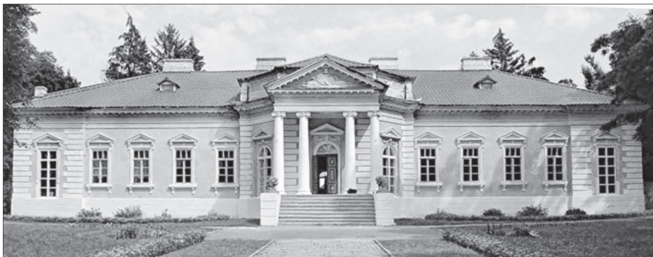
Rys. 2. Samczyki. Pałac, elewacja ogrodowa. Fot. W. Brzezińska-Marjanowska.
