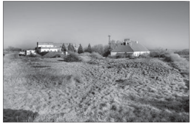
Рис. 6. Фото південного бастиону станом на 11.12.2015р. (фото автора).
