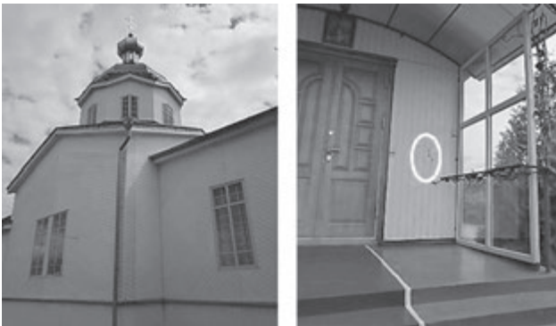
Рис. 3. Облицювання дерев'яних храмів ПВХ-вагонкою та її пошкодження під час експлуатації: Церква Преображення Господнього в с. Батьків Радивилівського району (зліва), фрагмент облицювання фасадів церкви Введення в Храм Пресвятої Богородиці, с. Башарівка Радивилівського району (справа). Фото Н.Лушнікової, липень 2016 р.
