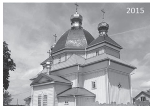
Рис. 1. Заміна покриттів з оцинкованої сталі на покриття з нітриду титану. Церква Преображення Господнього, смт Оржів Рівненського району. Фото П.А. Ричкова
