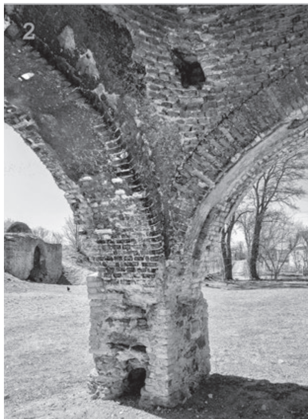
Рис. 7. «Огнище». Фрагменти південно-східної (1) та південно-західної (2) опор з отворами для «риништоку». Фото автора. 2015 р.
