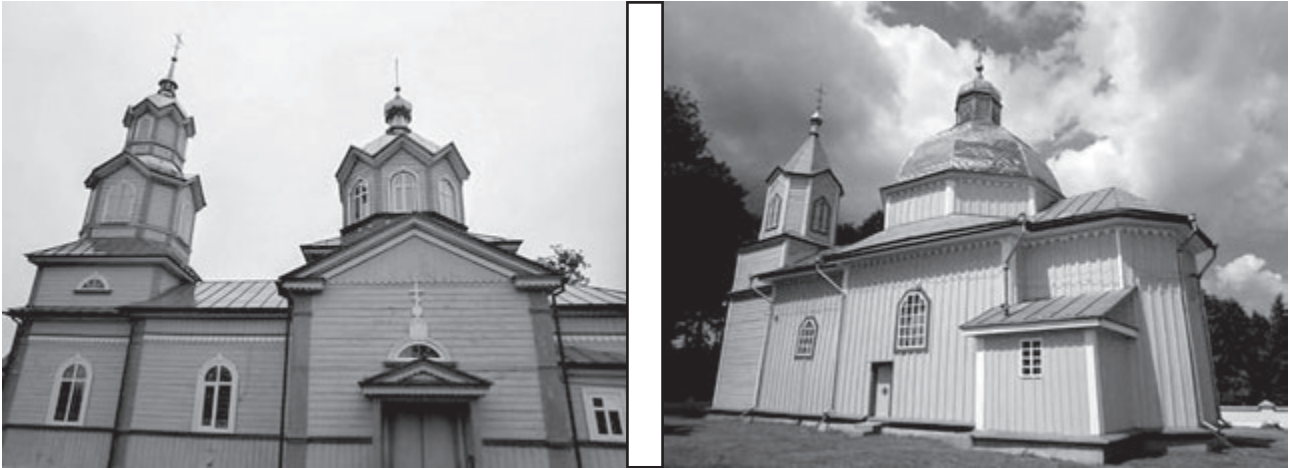
Рис. 6. Приклади фарбування фасадів олійною фарбою (зліва, церква Покрови Богородиці, с. Велика Омеляна Рівненського району, видимі відшарування фарби) та воднодисперсійною фарбою (справа, церква Св. Архангела Михаїла, с. Старожуків Рівненського району). Фото Н. Лушнікової, липень 2016 р.
