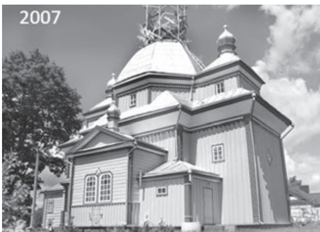
Рис. 1. Заміна покриттів з оцинкованої сталі на покриття з нітриду титану. Церква Преображення Господнього, смт Оржів Рівненського району. Фото П.А. Ричкова
