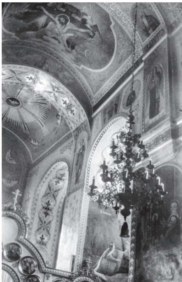
Рис. 8. Успенська церква в Зимно. Попружні арки в головній наві. Фото автора. 1997 р.
