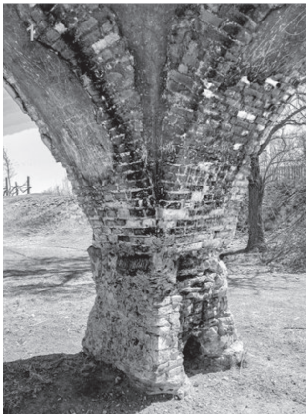
Рис. 7. «Огнище». Фрагменти південно-східної (1) та південно-західної (2) опор з отворами для «риништоку». Фото автора. 2015 р.
