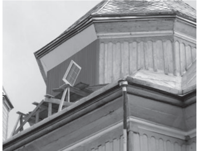
Рис. 4. Процес обшивання світлового барабану церкви Воскресіння Господнього профільованими металевими листами, с. Голишів Рівненського району. Фото П. Ричкова, липень 2016 р.
