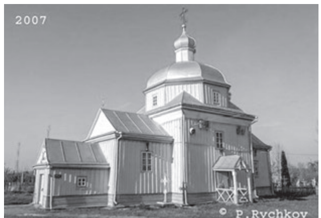
Рис. 5. Обшивка блок-хаузом церкви Успіння Богородиці, с. Караєвичі Рівненського району. Фото П. Ричкова
