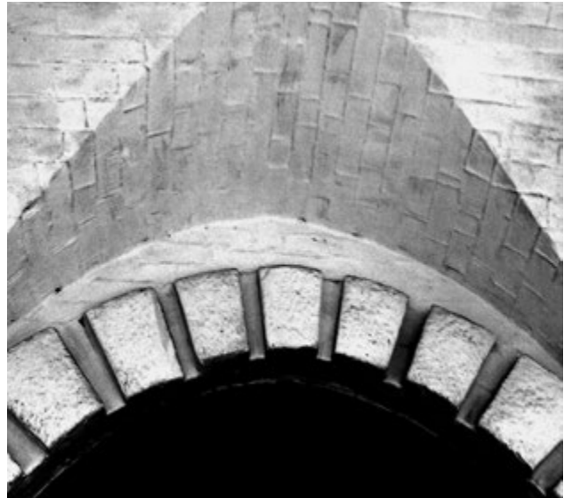
Рис. 5. Хрестове склепіння у внутрішній об'ємно-просторовій структурі вокзалу станції Маневичі. Фото автора. 2018 р.
