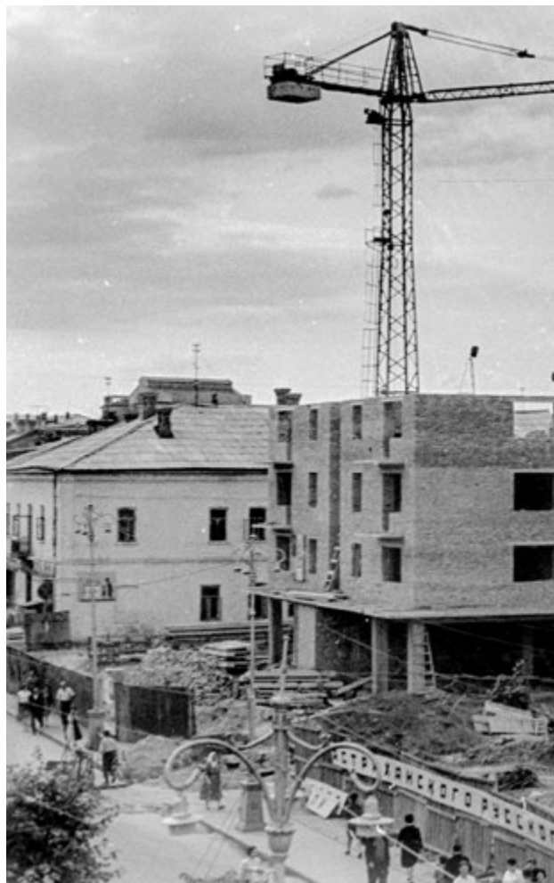
Рис. 11. Будинок по вул. Соборній, 94. Поряд розпочато будівництво багатоповерхівки. Кінець 1960-х — початок 1970-х рр. РОКМ
