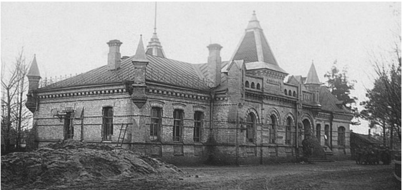
Рис. 3. Залізничний вокзал станції Маневичі. 1904 р. Фото. Поч. XX ст. [9]
