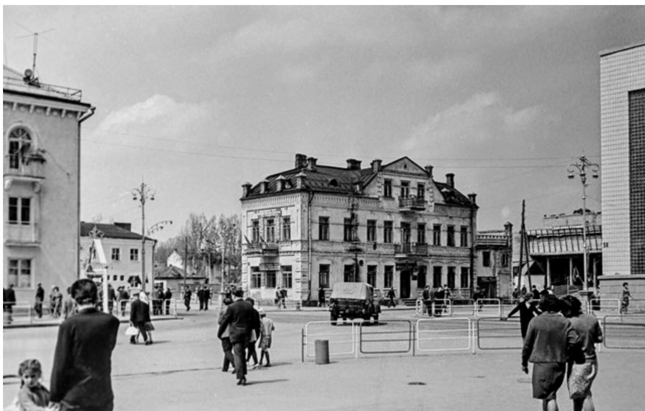
Рис. 15. Будинок коло поштамту знесений під час будівництва площі Леніна (тепер Майдан Незалежності). 1960-ті рр. РОКМ
