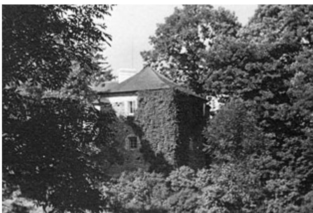
Рис. 5. Вигляд на південно-західну башту замкового комплексу. Фото Я. Булгака. 1937-1938 рр.
