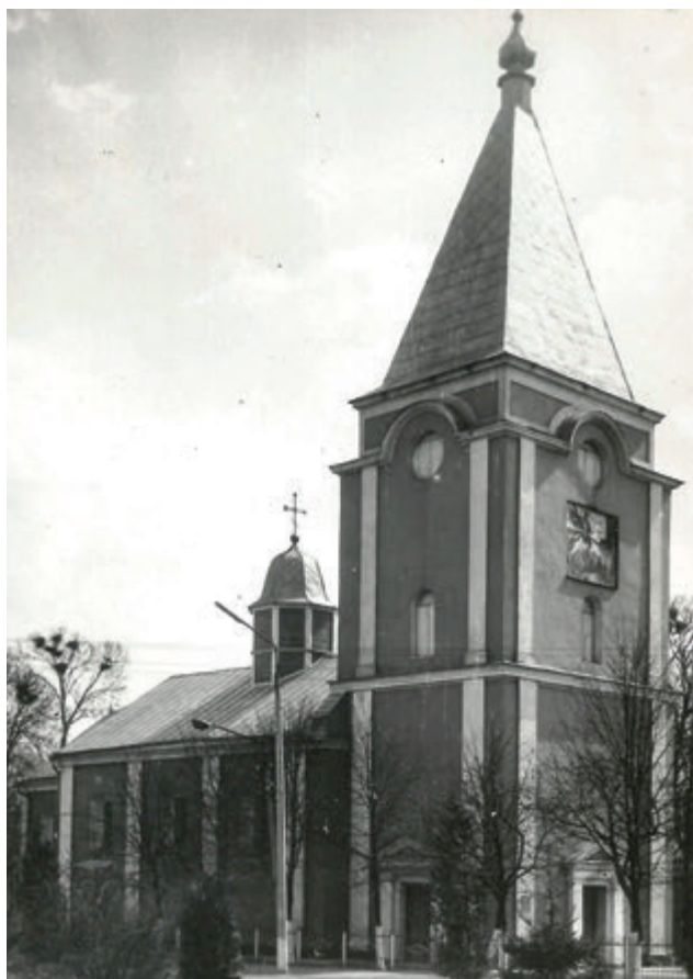
Рис. 13. Любомль. Церква св. Георгія. Вигляд з північно-західного боку. Фото В. Завади, 1986 р.
