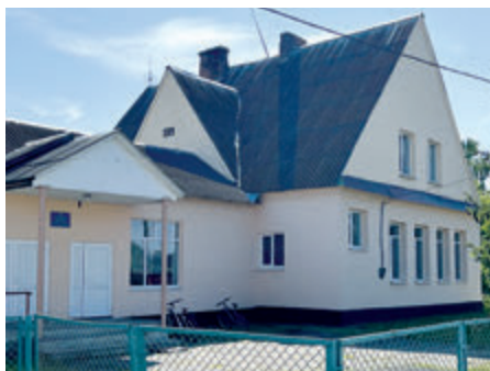
Рис. 14. с. Бірки. Школа. Колишні головний та бічні фасади шкільної будівлі 1920-х рр. Фото О. Лончук, 2023 р.
