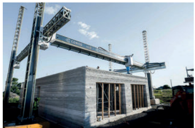
Рис. 4. Портальний 3D-принтер на місці будівництва будинку в Канаді. Фото з сайту cobod.com
