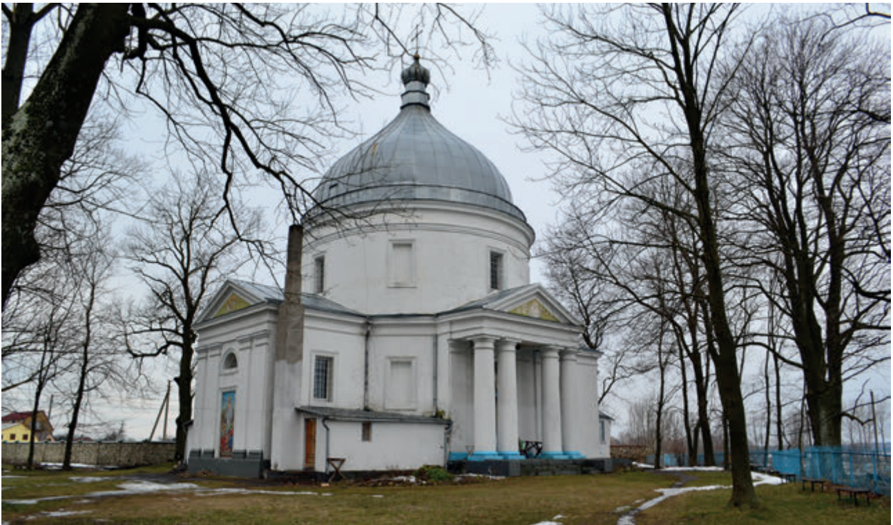
Рис. 45. Світязь. Церква. Вигляд з північного сходу. Фото С. Лончука, 2013 р.
