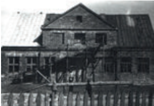
Рис. 28. с. Гупали. Будівництво школи. Фото 1937-1939 рр.
