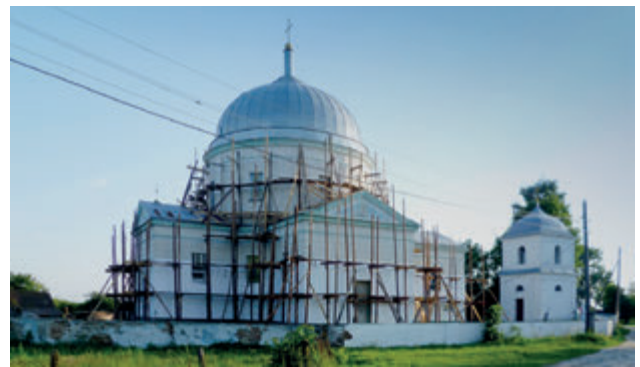
Рис. 39. Головне. Церква під час обклеювання пінопластом та дзвіниці. Фото В. Галевського, 2011 р.
