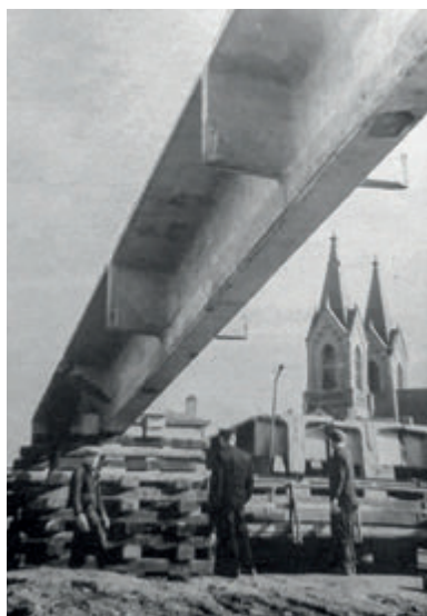
Рис. 16. Фото періоду будівництва шляхопроводу через річку Устю 1962-1963 рр.
