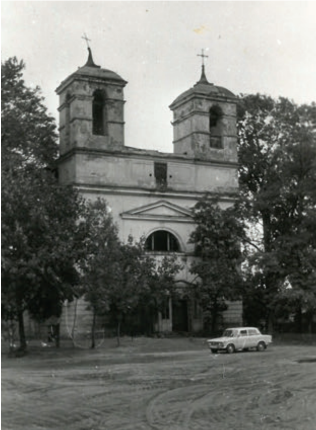
Рис. 28. Шацьк. Церква Різдва Пресвятої Богородиці. Західний фасад. Фото В. Завади, 1986 р.
