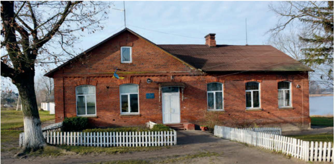
Рис. 4. с. Піща. Школа. Східний фасад з головним входом. Фото С. Лончука, 2017 р.
