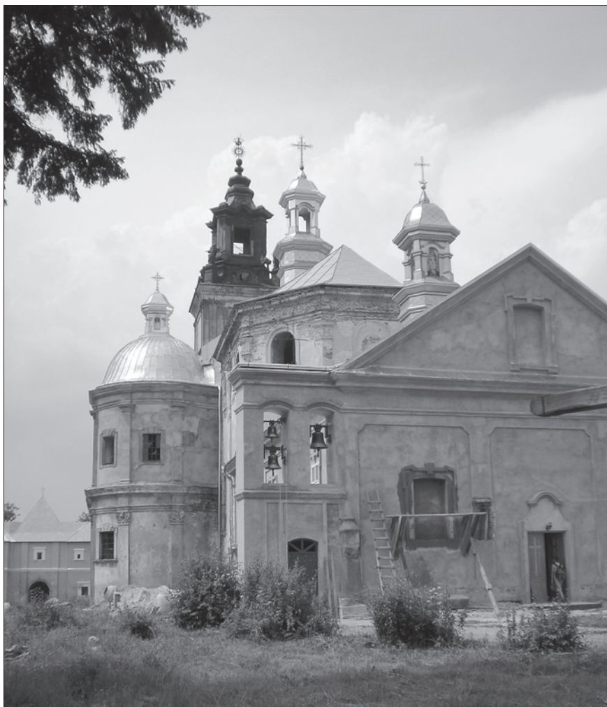
4. Фасад колишнього ораторіуму 1760-1762 рр. Зліва від входу на пілястрі видно пусте місце, оскільки в цей час таблиця з написом у зв'язку з ремонтними роботами була тимчасово демонтована. Фото В. Ульянова 27 червня 2006 р.
