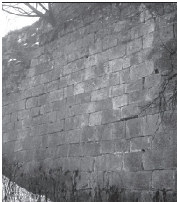
Застосування різаних кам'яних блоків для лицьовання оборонних стін Підкамінського монастиря
