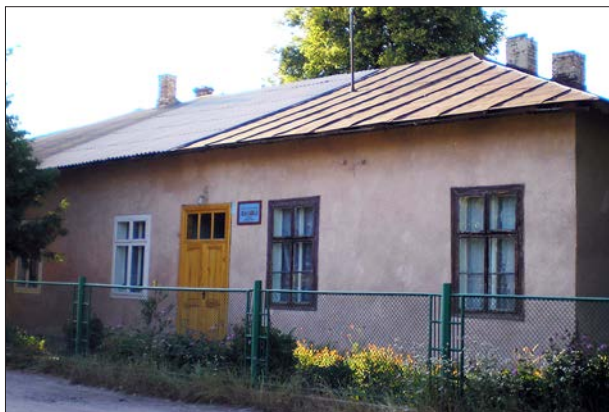
10. Будівля колишнього монастиря сестер-служебниць, липень 2006 р.
